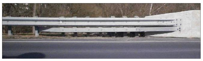
ELEVATION VIEW FOR TYPICAL CONCRETE BRIDGE BARRIER TRANSITION
